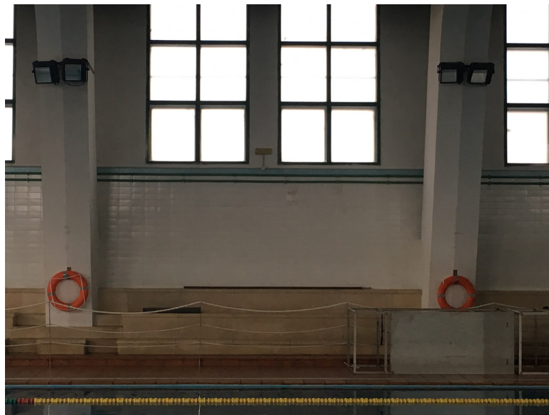
Figura 3-11 Pared lateral del Recinto
