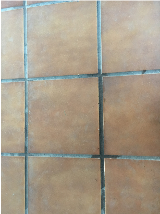
Figura 3-6 Suelo de Baldosas del Recinto
