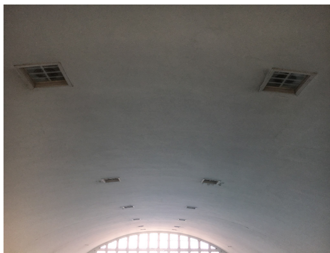
Figura 3-12 Techo del Recinto
