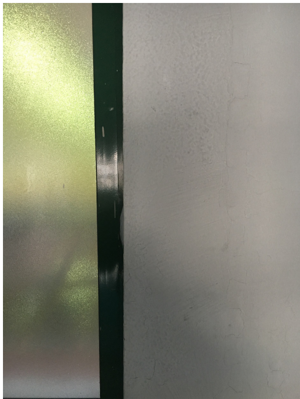
Figura 3-9 Ventana de Vidrio y Pared de enlucido de yeso del Recinto
