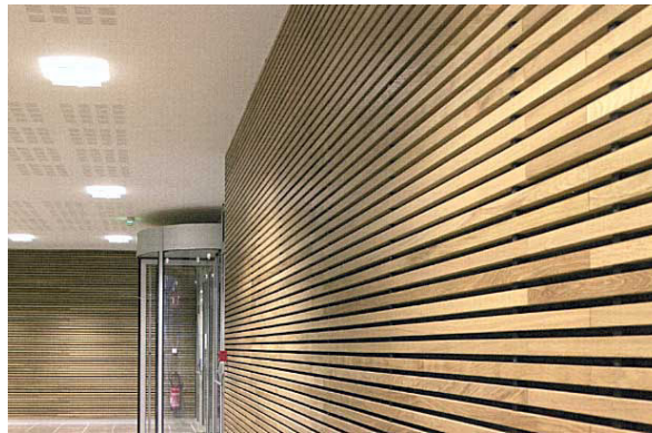
Figura 3-31 Recinto con sistema fonoabsorbente de paneles de madera laminada [18]
