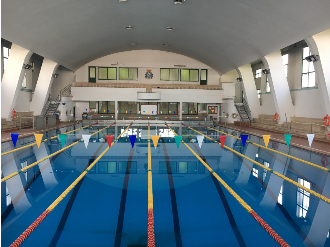
Figura 3-3 Vista parte anterior del Recinto
