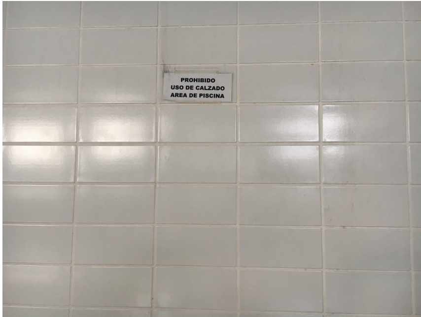
Figura 3-10 Pared de Baldosas del Recinto
