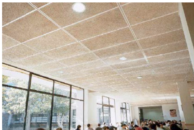
Figura 2-16 Falso techo acústico fibras de madera aglomeradas [8]
