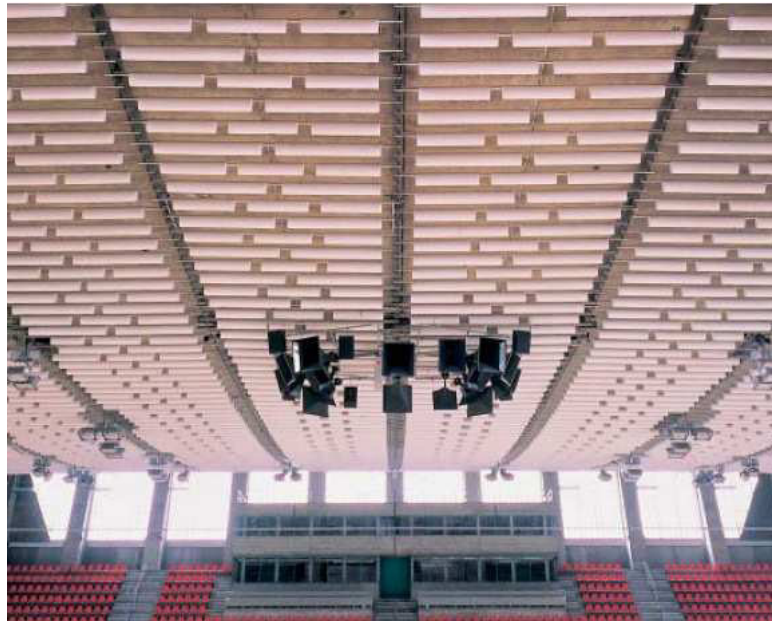
Figura 3-29 Recinto con sistema de baffles absorbentes acústicos [9]
