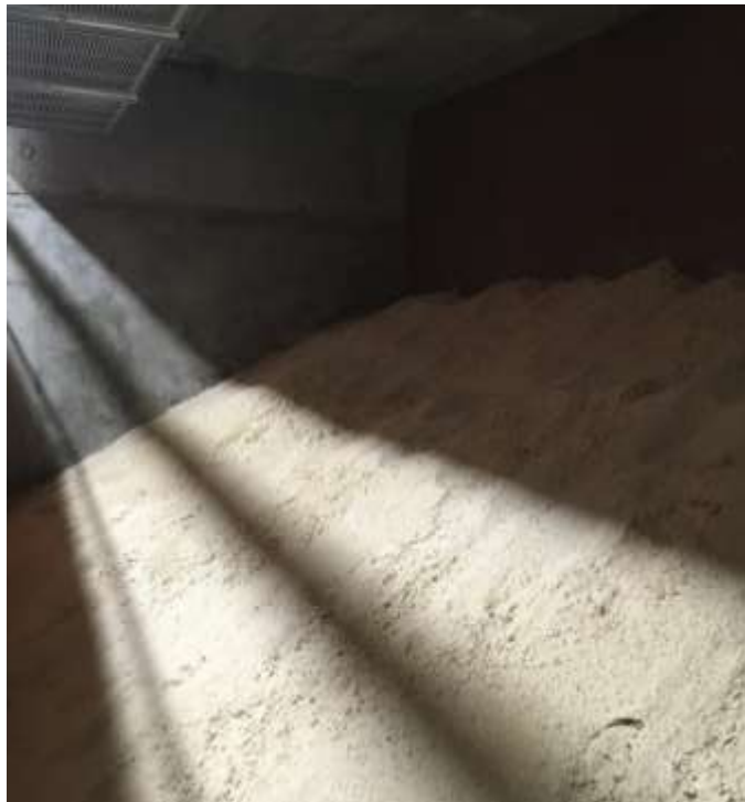
Figura 2-11 Talud de arena de sílice parabalas. (Elaboración propia)
