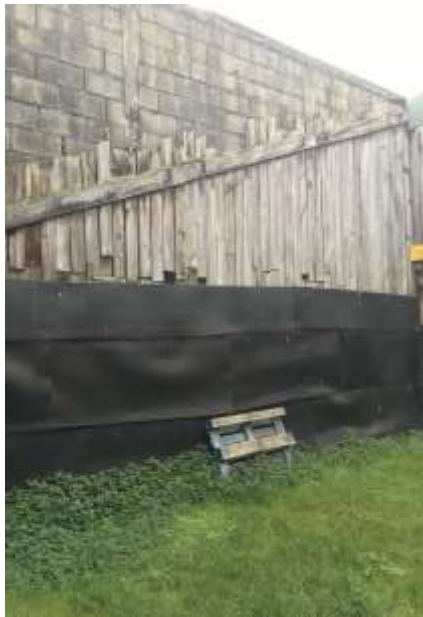
Figura 4-5 Detalle del revestimiento del muro oeste. (Elaboración propia)
