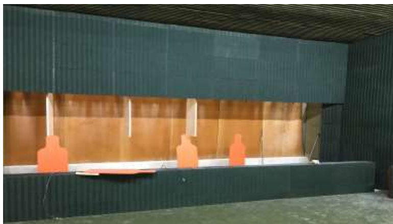
Figura 2-14 Muretes protectores (Superior e inferior). (Elaboración propia)
