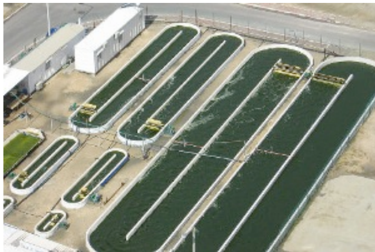
Figura 2-10 Tanque de canalización [74]
