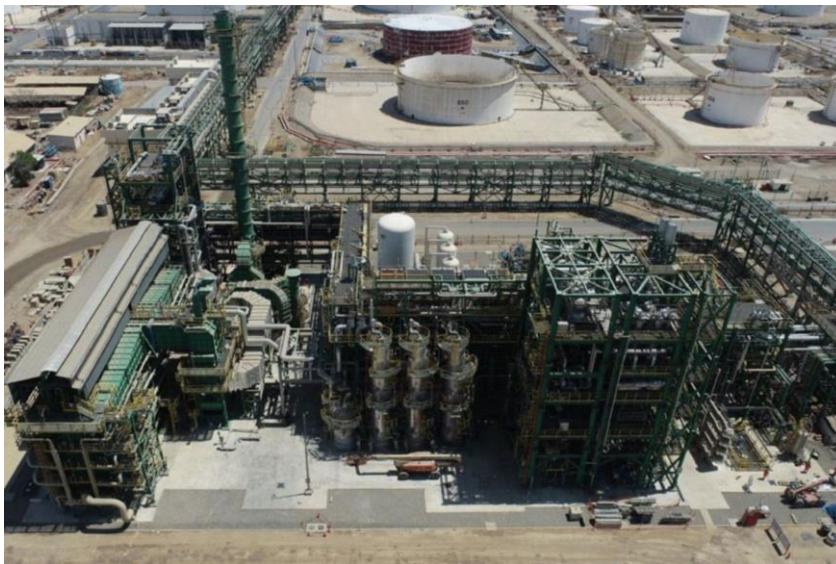
Figura 2-4. Planta de hidrógeno en la Nueva Refinería Talara (Perú), donde se obtiene el hidrógeno necesario para sus procesos de refinado. [15]
