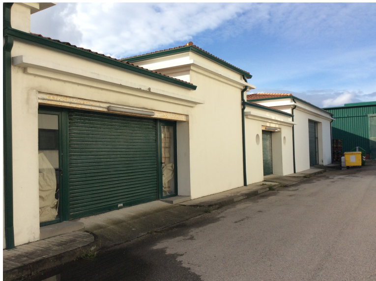
Figura AIV-2 Almacenes Sur cara Este
