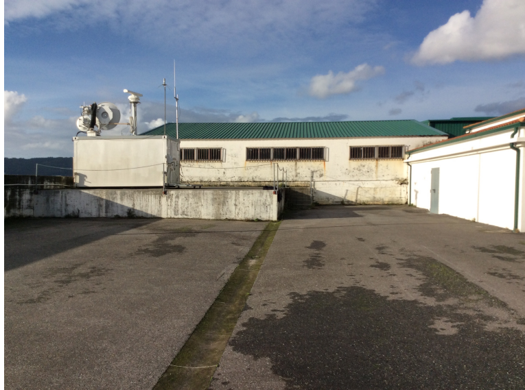
Figura AIV-1 Galería de tiro cara Sur
