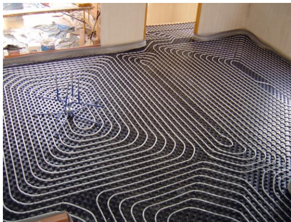
Figura 3-6. Instalación de un suelo radiante en una vivienda. Fuente [7]
