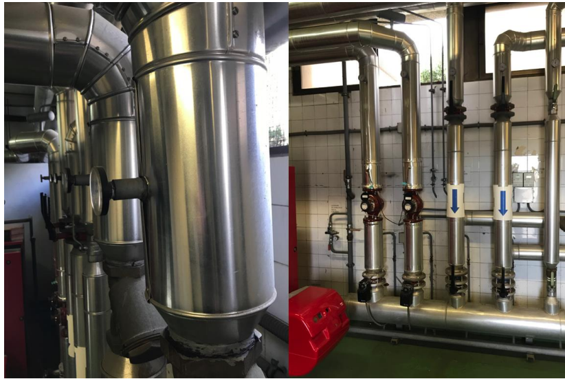
Figura 6-9. Termómetros bimetalicos (izq.) y Retornos (dcha.). Elaboración propia
