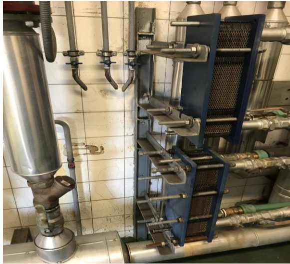
Figura 5-16. Sujeción de los intercambiadores. Elaboración propia
