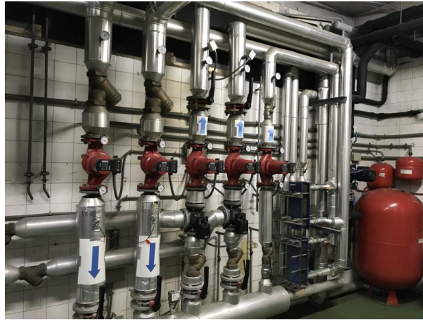
Figura 5-4. Circuitos de calefacción y ACS. Elaboración propia
