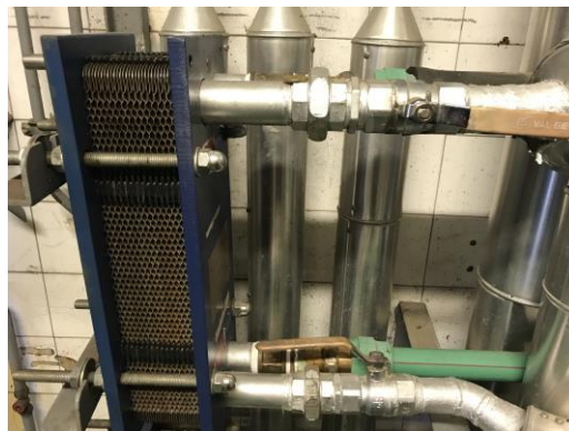
Figura 5-17. Entradas y salidas en los intercambiadores. Elaboración propia
