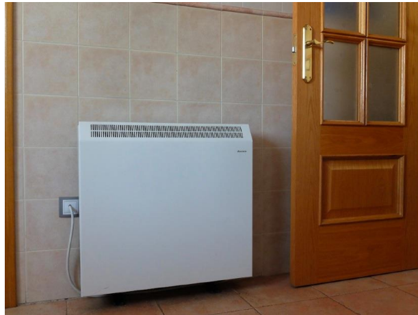
Figura 3-5. Acumulador de calor estático. Elaboración propia
