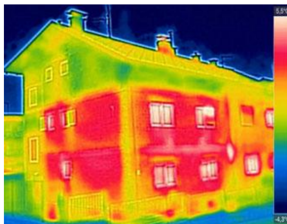
Figura 2-15 Termografía infrarroja de una fachada, con escala de temperaturas (°C) (Extraído de [31])
