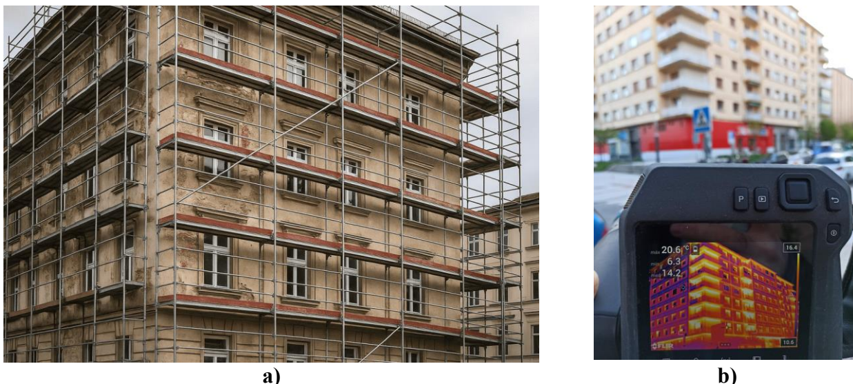
Figura 2-3 Comparación entre métodos tradicionales de inspección y técnicas no invasivas: (a) inspección convencional mediante medios auxiliares y acceso directo a la fachada, (b) inspección mediante termografía infrarroja realizada a distancia sin contacto con el edificio (Extraído de: a) [18], b) [19])
