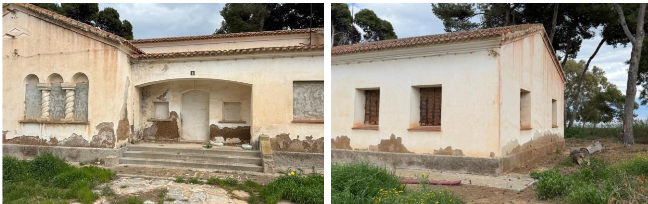
Figura 2-1 Viviendas residenciales pertenecientes al Ministerio de Defensa, ubicadas en la Ciudad del Aire de San Javier (Murcia), construidas en entorno marítimo y que presentan procesos de envejecimiento y degradación superficial asociados a la exposición prolongada (Elaboración propia)
