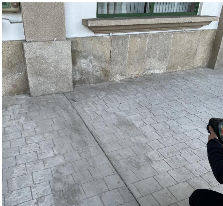
Figura 3-19 Captura de imágenes termográficas del paramento mediante termografía pasiva (Elaboración propia)
