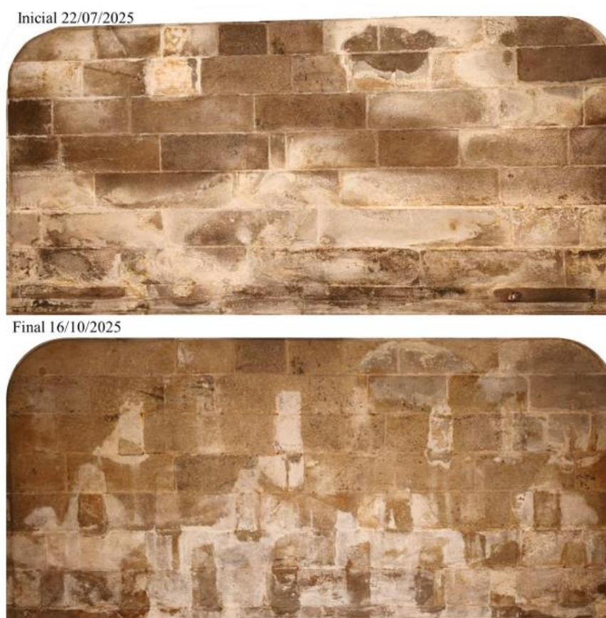
Figura 2-9 Imágenes del paramento pétreo correspondientes a distintas fases del proceso de desalación, mostrando el estado inicial con presencia de eflorescencias salinas (imagen superior) y el estado final tras la aplicación del tratamiento (imagen inferior), documentadas en la Capilla de la Catedral de Lugo. (Extraído de [24]).
