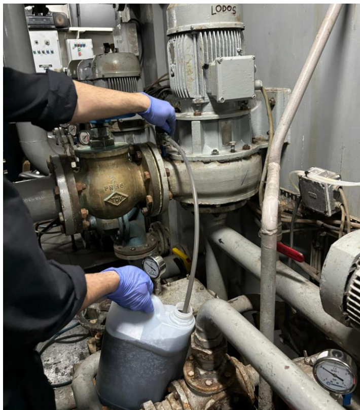
Figura 3-13 Obtención de lodos en el buque Patiño (elaboración propia).
