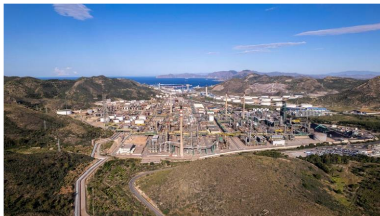
Figura 2-27 Instalaciones de Repsol en el Valle de Escombreras (Cartagena) [73].
