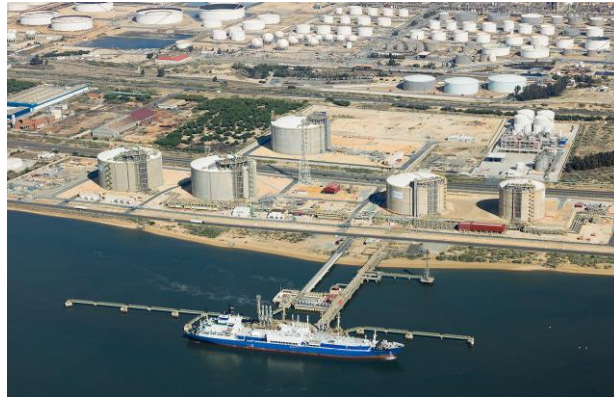
Figura 4-6 Planta de regasificación de Huelva [59]
