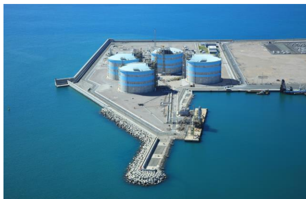
Figura 4-10 Planta de regasificación de Sagunto [59]
