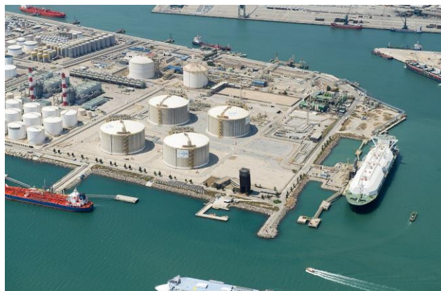
Figura 4-5 Planta de regasificación de Barcelona [59]
