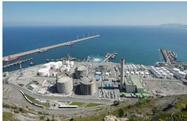
Figura 4-9 Planta de regasificación de Bilbao [59]
