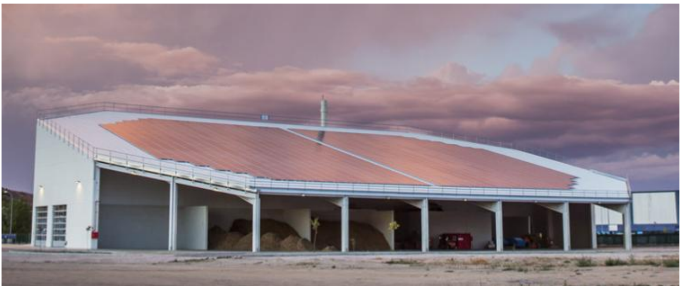
Figura 2-1 Central de trigeneración con biomasa y energía solar para uso industrial en la fábrica de L’Oréal en Burgos [3]
