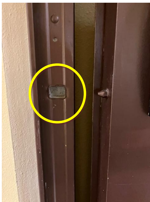
Figura 3-12: Hueco para el cierre de la puerta. (Elaboración propia).
