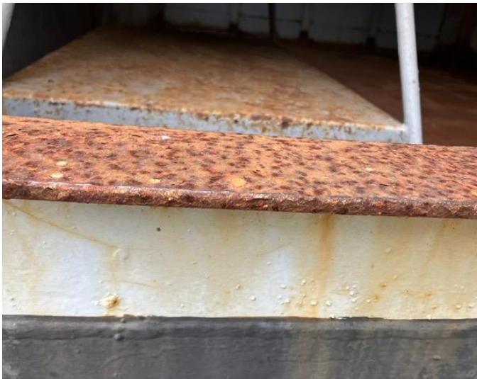
Figura 3-15: Parte inferior del marco de la puerta. (Elaboración propia).
