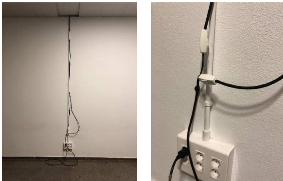
Figura 3-75 Derivación eléctrica de la instalación provisional
