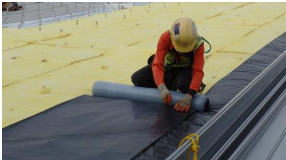
Figura 2-4 Operario instalando barrera de protección de radón [29]
