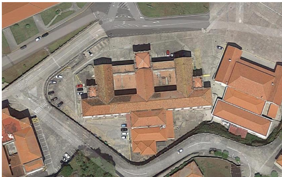
Figura 3-2 Vista aérea del edificio – Google Earth
