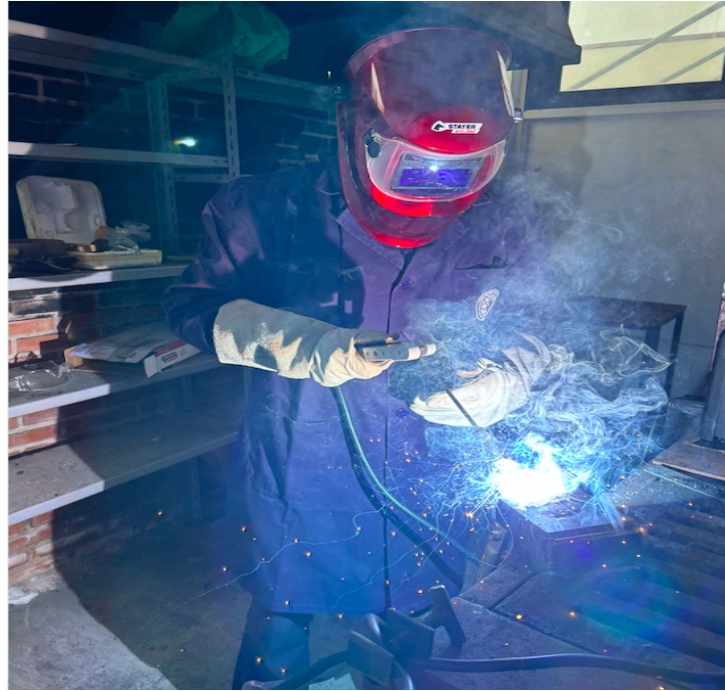
Figura 3-10 Autor del trabajo fin de grado soldando placas de acero para crear el sarcófago (fuente propia)
