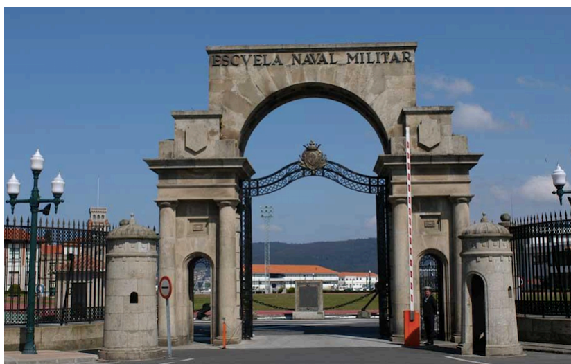
Figura 1-1 Puerta de Carlos I
