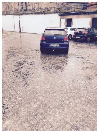
Figura 4-2 Fotografía tomada a 5 metros
