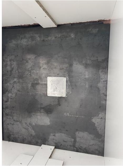
Figura 3-2 Chapa con fresado central realizado (Elaboración propia)
