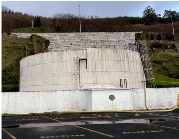
Figura 3-1 Tanque 16 de las instalaciones del Vispón, Ferrol, imagen propia.
