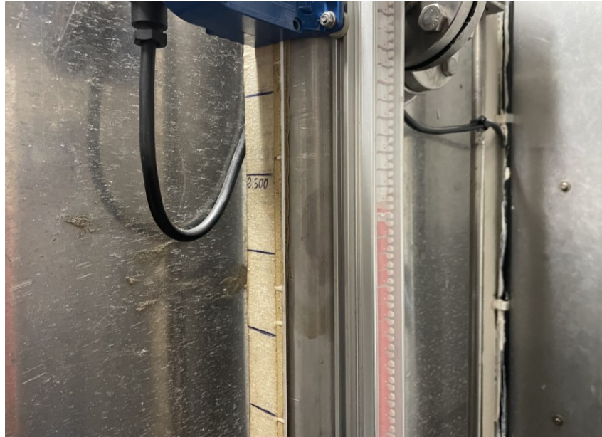
Figura 3-6 Indicador de nivel del tanque de babor de L.I. GM Salas (fuente propia)
