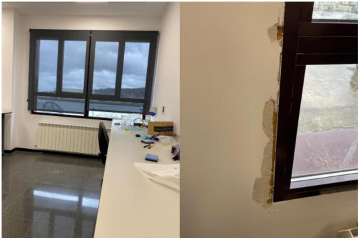
Figura 0-2 Imágenes del Aula Multiusos
