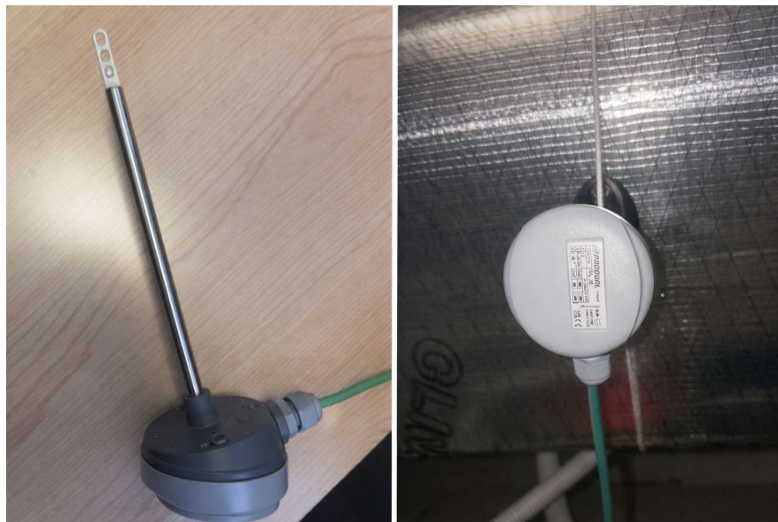
Figura 3-7 Sonda IVL-20.
