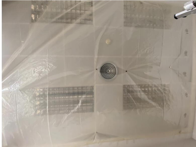
Figura 3-10 Falso techo cubierto con plástico
