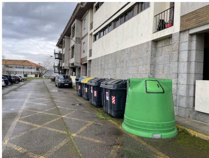
Figura 3-18 Contenedores del cuartel Almirante Francisco Moreno.
