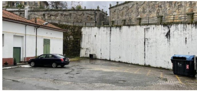
Figura 3-53 Ubicación de contenedores de compostaje.
