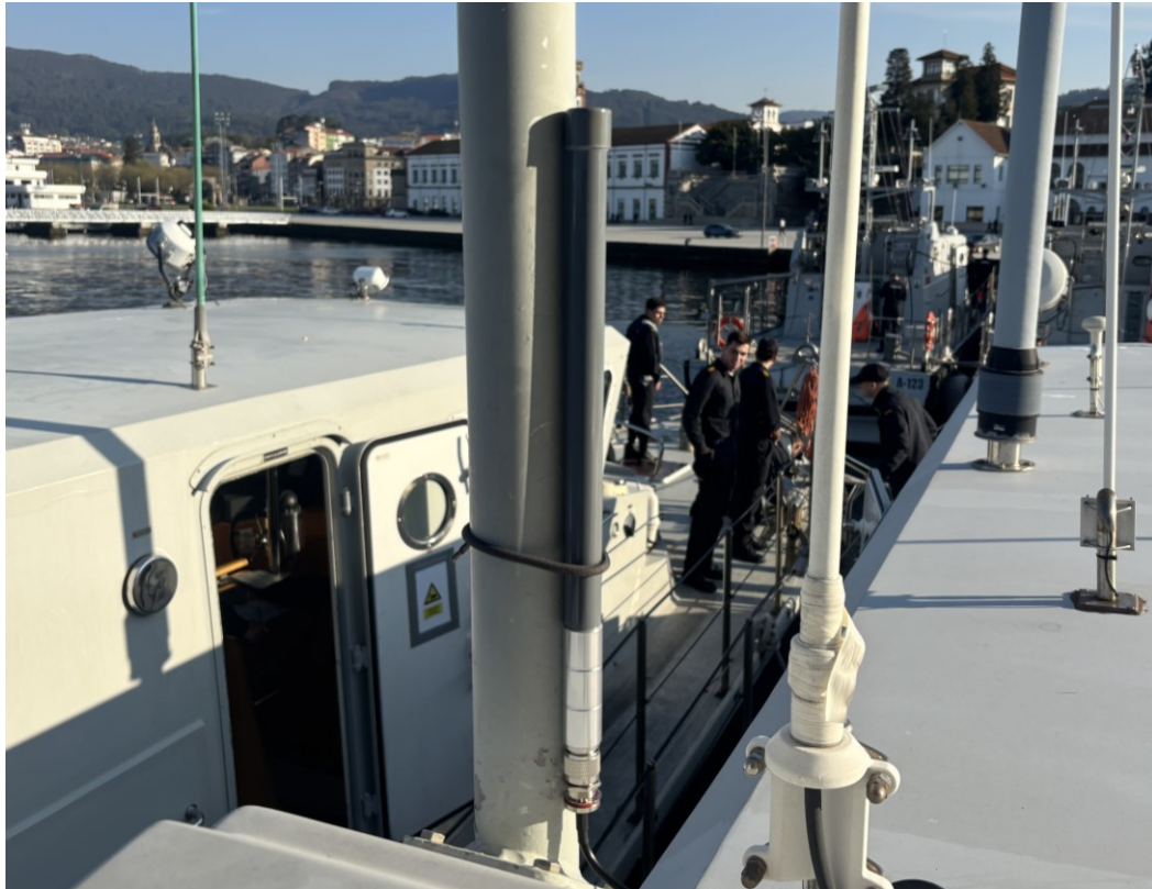
Figura 5-10 Instalación provisional de la antena para las pruebas.
