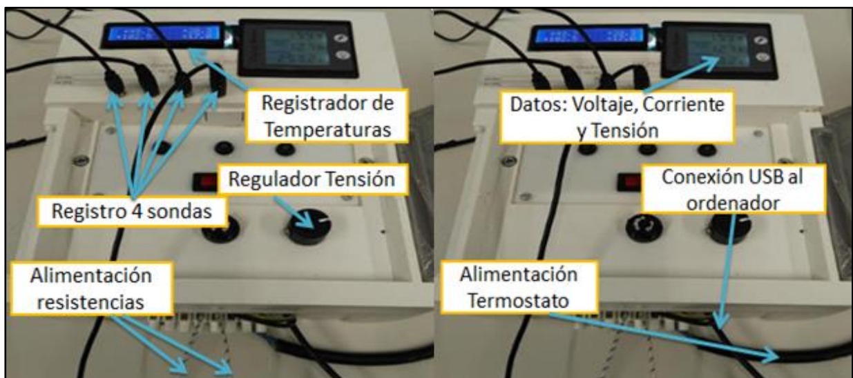
Figura 3-12 Elementos ubicados en la fuente de alimentación.
