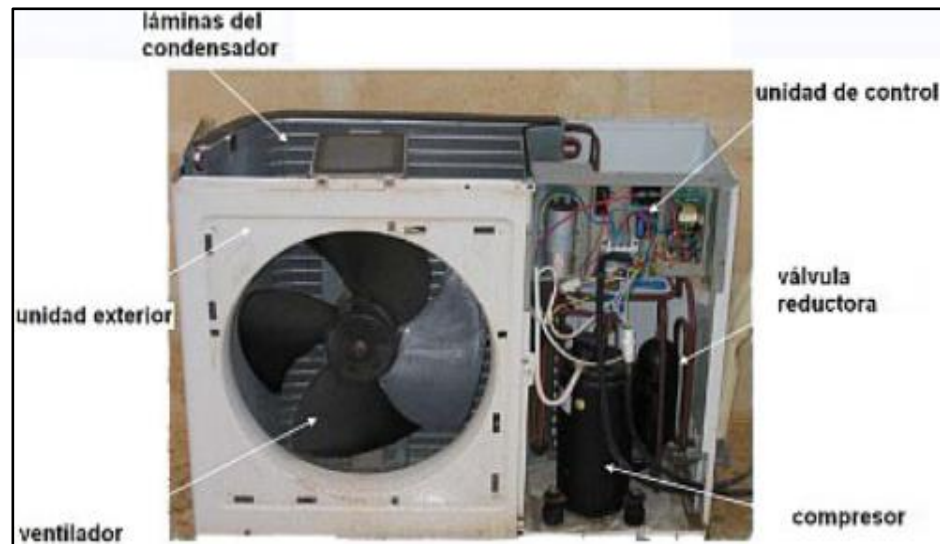
Figura 5-1 Equipo exterior aire acondicionado convencional con sus elementos.
