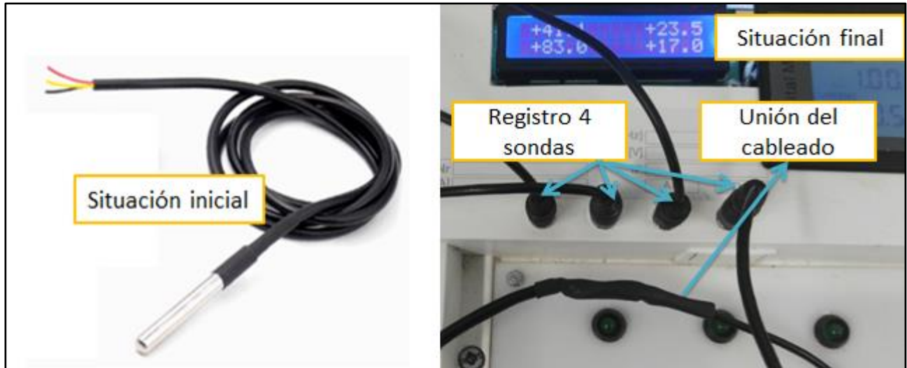
Figura 3-10 Situación inicial y final de las sondas empleadas.
