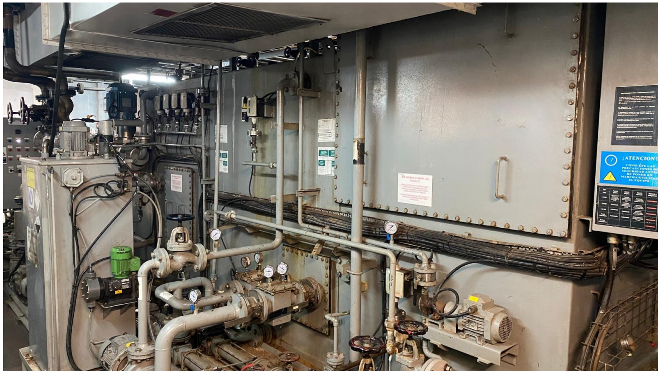
Figura 3-2 Planta de tratamiento del Cantabria.
