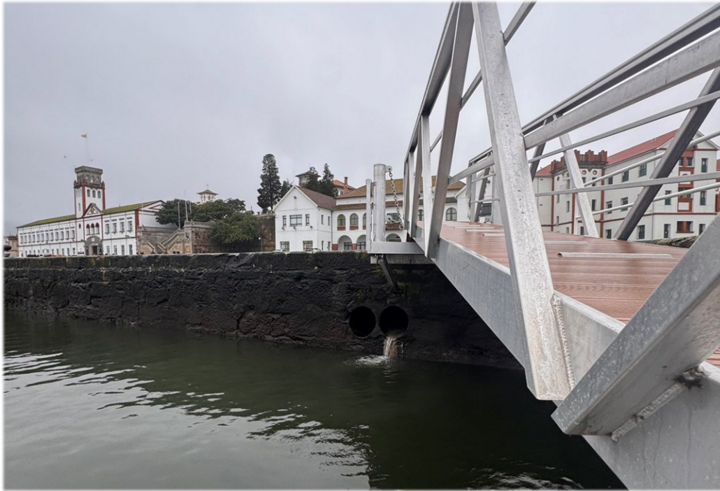
Figura 3-5. Vista general del entorno inmediato del punto de vertido dentro del recinto portuario.
