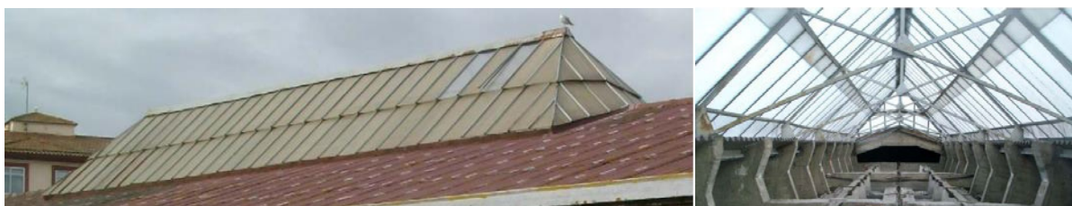
Figura 3-5 Vista del lucernario desde el exterior y el interior [32]
