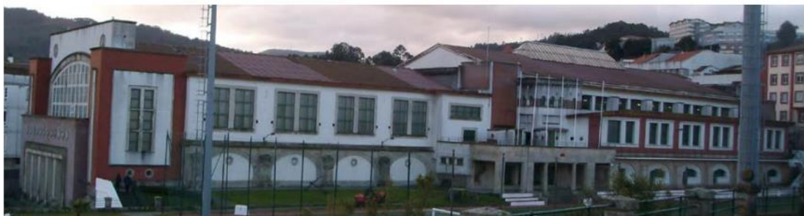
Figura 3-4 Vista de las fachadas Norte y Oeste del gimnasio [Autoría propia]
