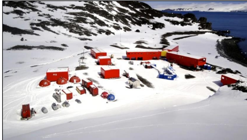
Figura 2-6 Base Juan Carlos I en la Antártida remodelada por Tecnové S.L [16]
