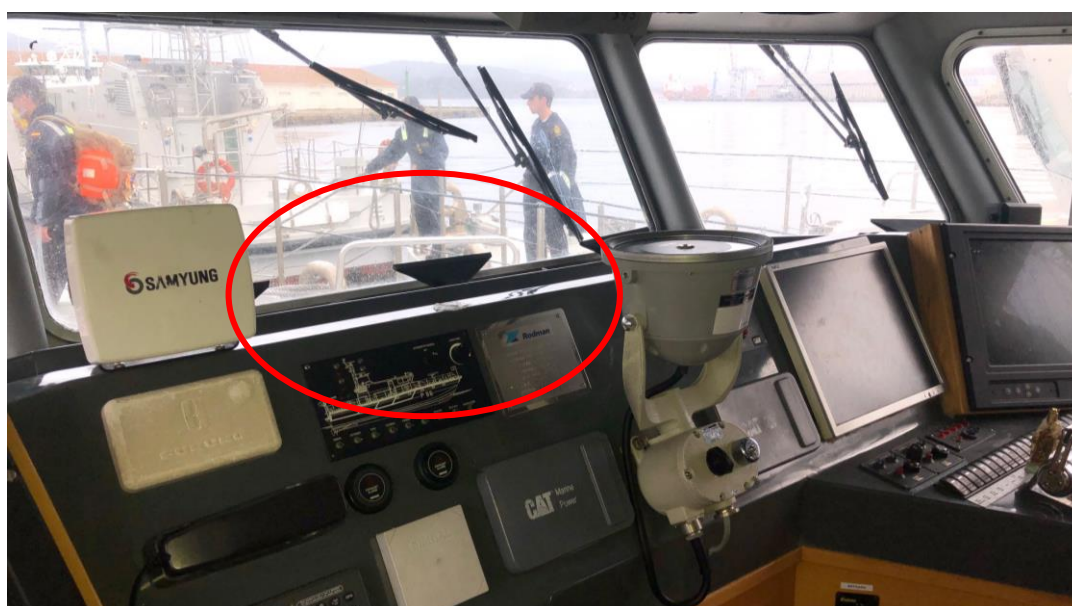
Figura 3-3 Visión general superficie de instalación [Autoría Propia]
