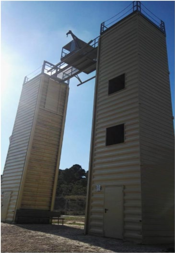
Figura 2-6 Vista frontal torre multifunción FGNE
