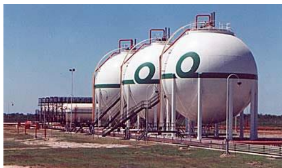
Figura 2-1 Depósitos esféricos [30]
