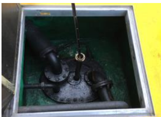
Figura 2-3 Ejemplo de entrada de depósito enterrado
