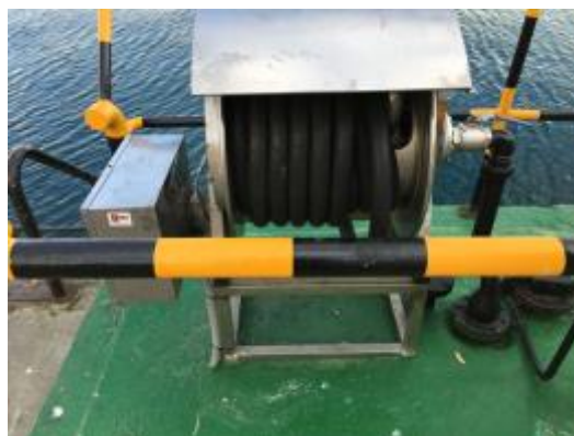
Figura 3-14 Ejemplo de manguera recogida en surtidor
