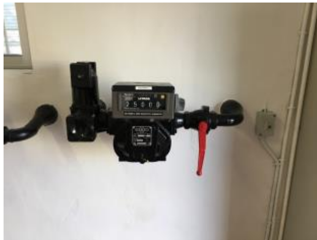
Figura 3-16 Contador de suministro en litros
