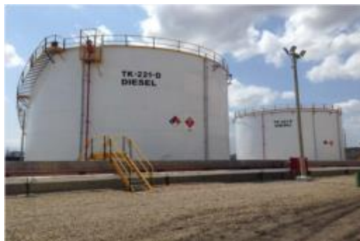
Figura 1-9 Tanque atmosférico para diésel de gran capacidad [25]
