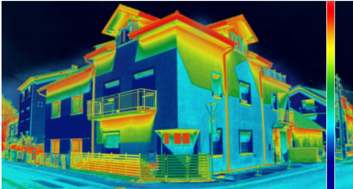
Figura 2-7 Imagen capturada con cámara termográfica [11]
