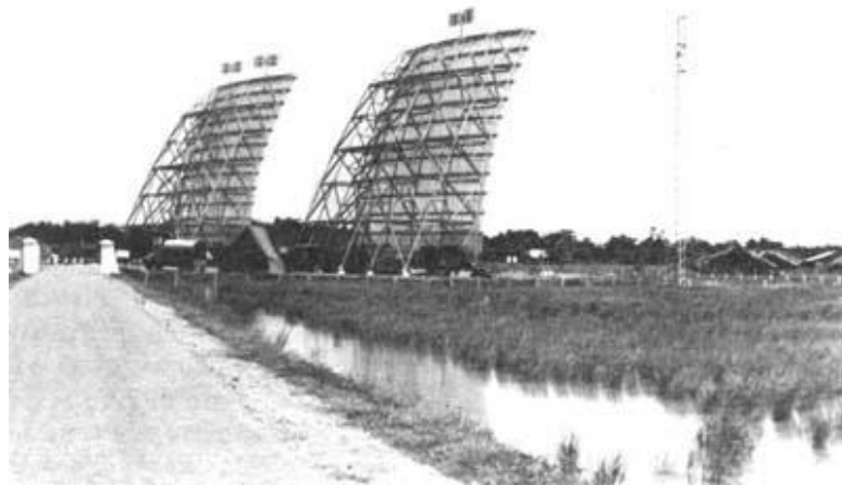
Figura 7-1 Antenas tipo 'billboard' del sistema Back Porch en Phu Lam (1962) [7]
