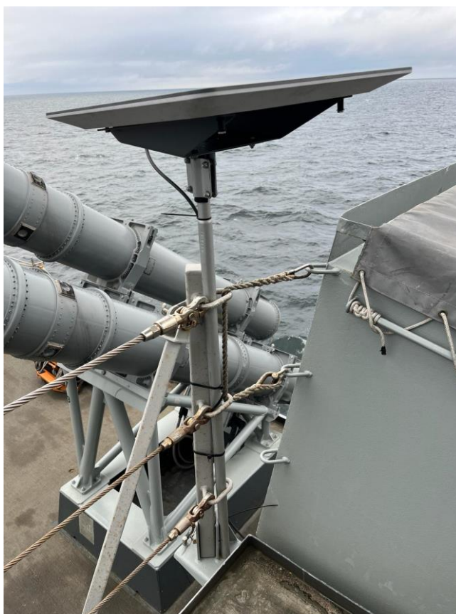
Figura 13.- Antena Starlink instalada en buque de la Armada. Fuente: Oficial de Comunicaciones de la fragata F-102. Última visita: 12/11/2024
