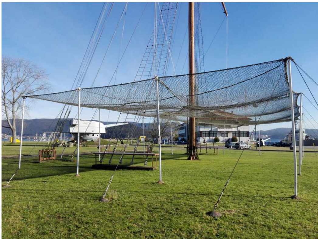
Figura 2-23 Fotografía de la red de seguridad del palo de señales de la ENM
