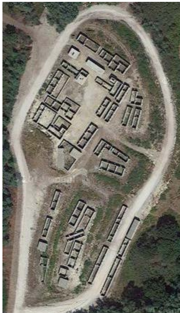
Figura 1-2 Vista aérea del poblado afgano para prácticas de combate en población en Base General Morillo (1)
