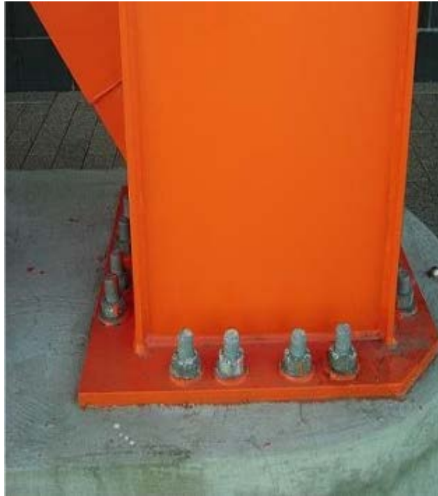
Figura 4-13 Fotografía de columna en apoyo fijo (12)
