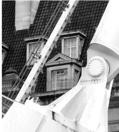
Figura 4-15 Fotografía de apoyos del London Eye (12)
