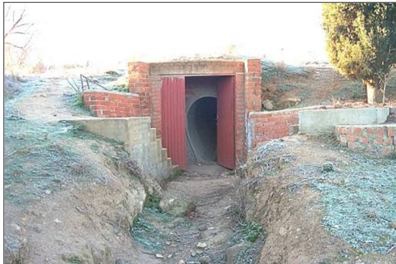
Figura 2-19 Alcantarillado en CMT Alíjares (5)
