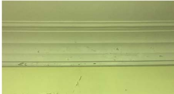
Figura 3-12 Transición de materiales en el techo.
