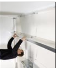
2 Instalar perfil de suspensión.
