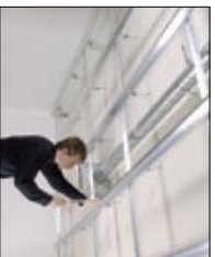
4 Colocar perfil secundario cada 1200 mm.
