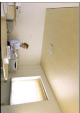
Falso techo sin perfil de pared.
