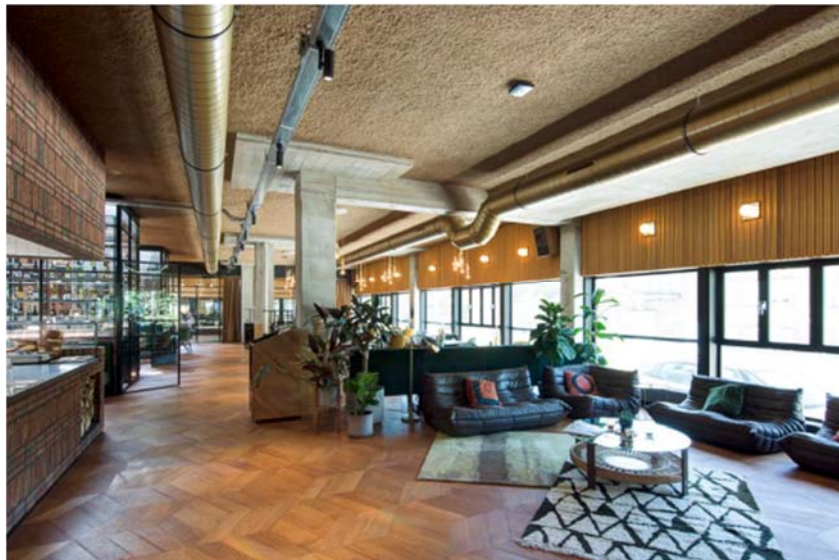
Figura 3-24 Acabado de un techo tratado con celulosa proyectada. [17]
