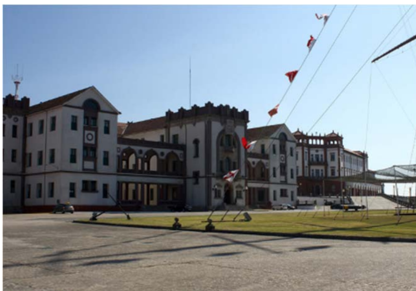
Figura 3-1 Imagen de la fachada del edificio Marqués de la Victoria. [9]
