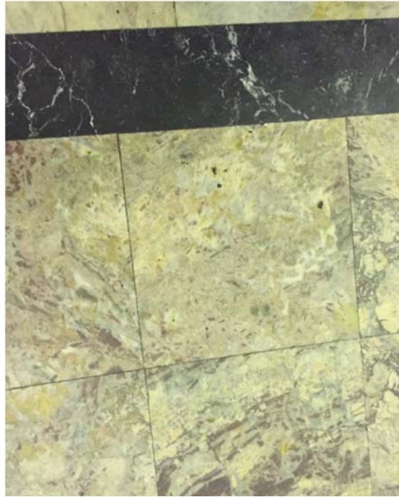
Figura 3-7 Detalle del suelo del comedor.
