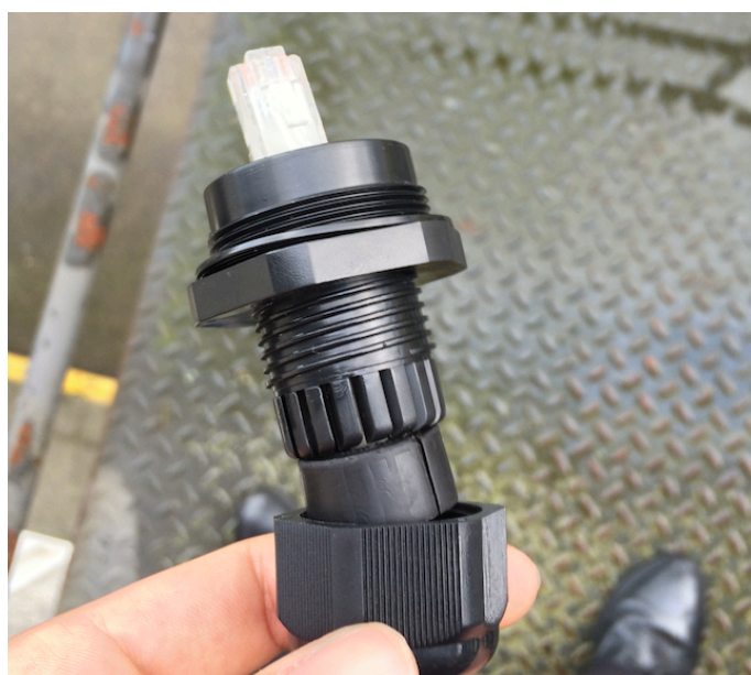
Figura 3-4 Sellamiento del cable CAT5
