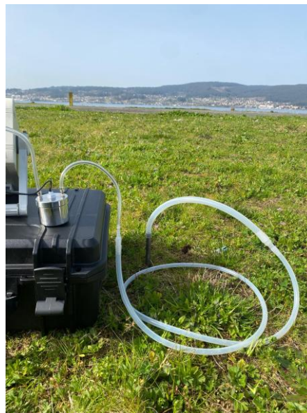
Figura 3-19 Conexión entre sonda y RTM 1688-2 mediante tubos.
