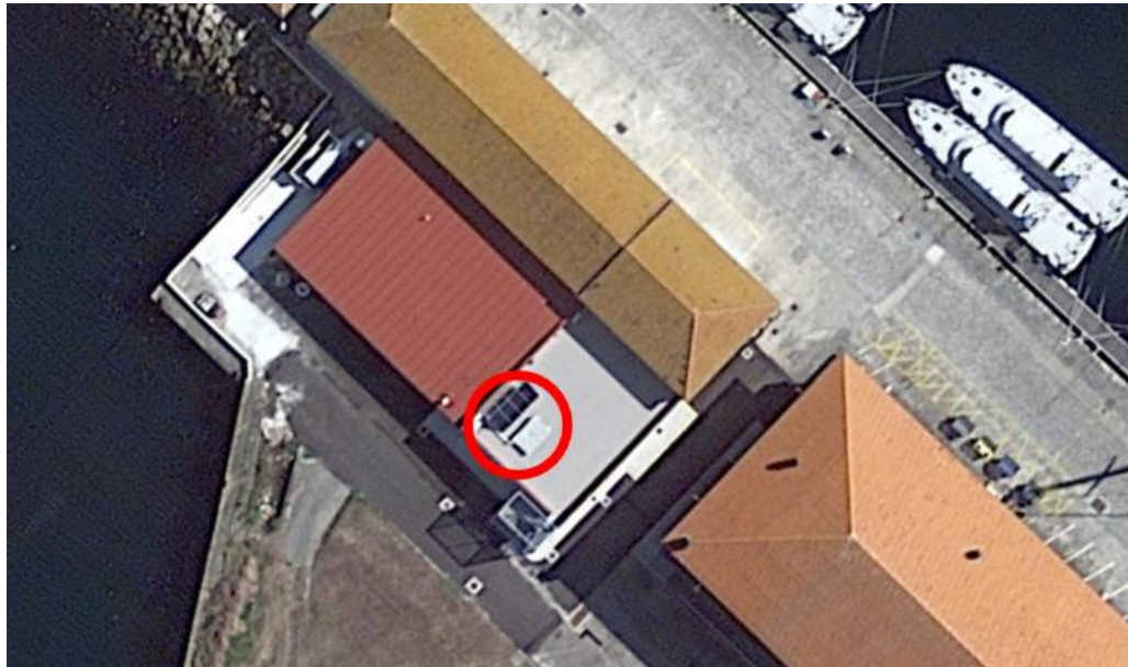
Figura 4-2 Cubierta superior del edificio donde se encuentra el captador solar. [20]
