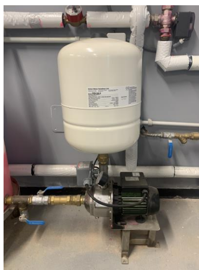
Figura 4-11 Vaso de expansión conectado al interacumulador
