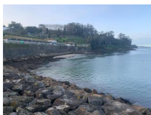
Figura 4-19 Zona de Pruebas II zona industrial [21]
