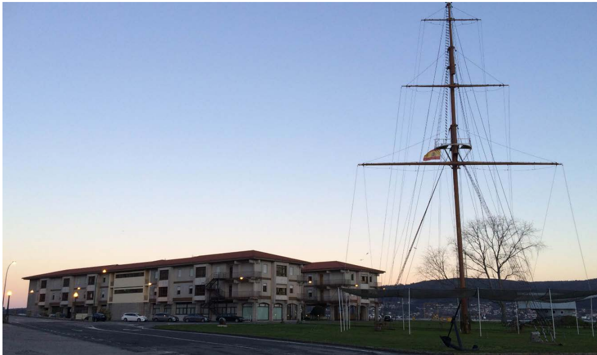
Figura 5-2 Detalle del cuartel Francisco Moreno y palo de señales. Fuente elaboración propia
