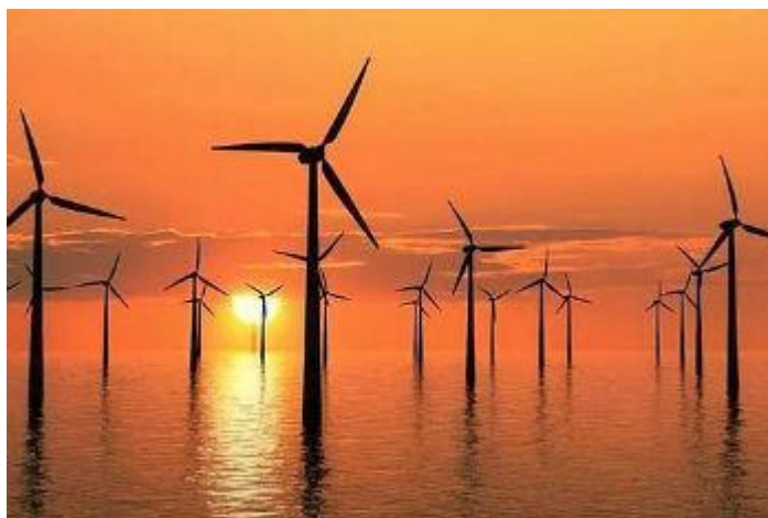
Figura 1-6 Parque eólico de London Array [11].
