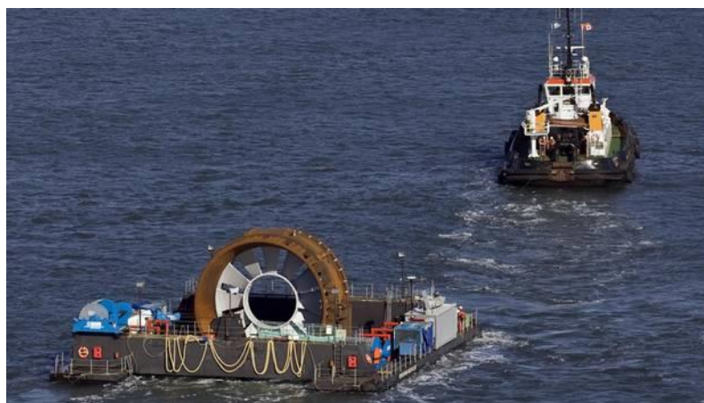
Figura 2-4 Traslado de la turbina para su instalación en la Bahía de Fundy [20].
