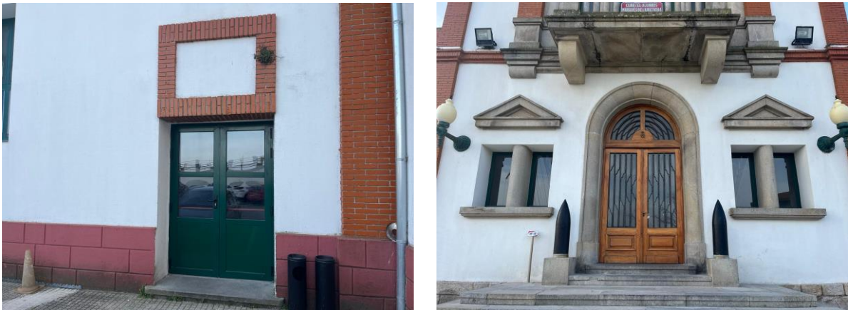
Figura 3-12 Puertas exteriores del edificio.
