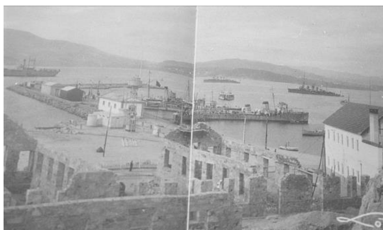
Figura 3-3 Fase de construcción del edificio inicial (año 1929) [15].
