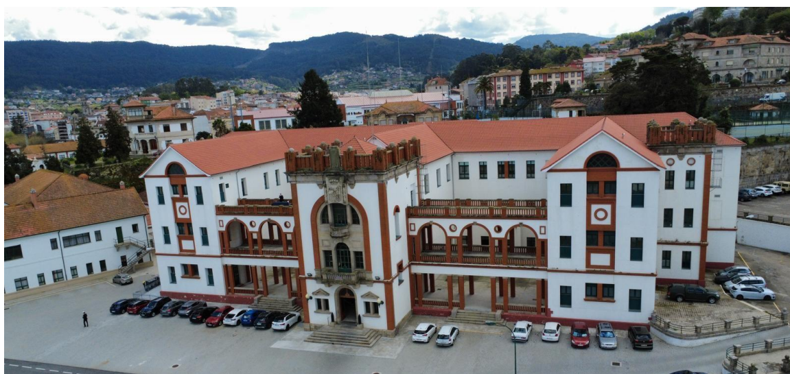
Figura 3-6 Estado actual del edificio cuartel MDV.
