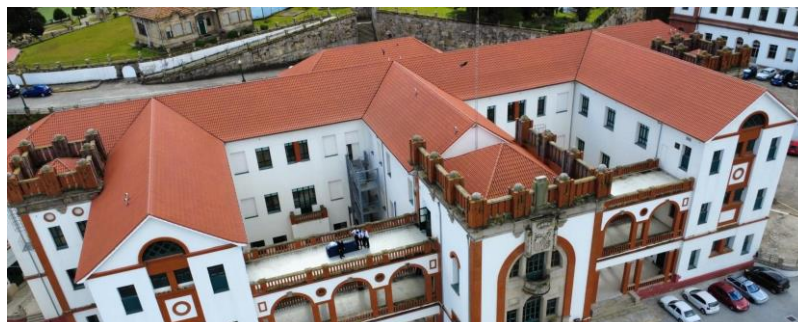
Figura 3-16 Cubierta del edificio.
