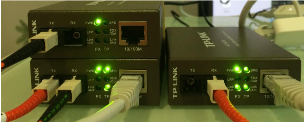
Figura 3-7. Montaje de los convertidores
