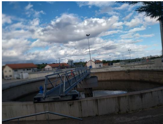
Figura 2-1 EDAR Tres Cantos (autoría propia)
