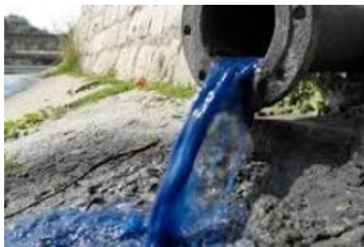
Figura 2-3 Aguas residuales industriales [8].
