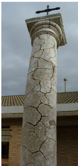
Figura 2-3 Alteración ocasionada en una columna de alabastro, situada en el convento de las carmelitas descalzas en Zaragoza, por cambios dimensionales de retracción y expansión debido a procesos periódicos de insolación [9]
