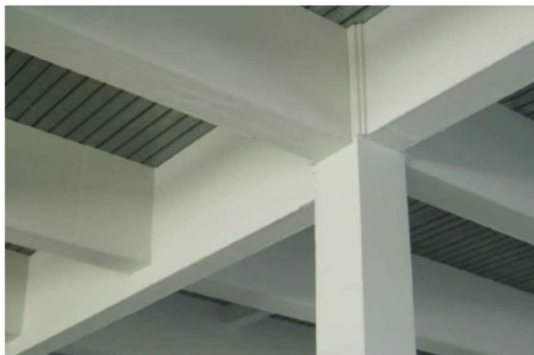
Figura 2-11 Pintura intumescente aplicada
