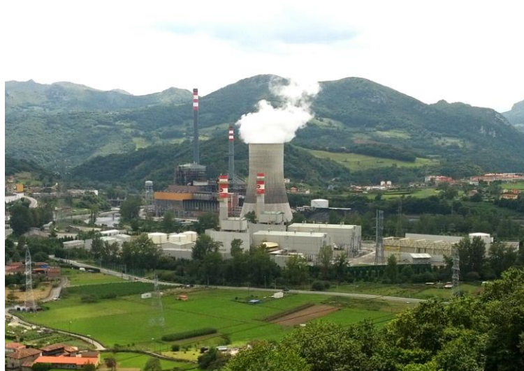
Figura 2-5 Central térmica de Soto de Ribera [9]
