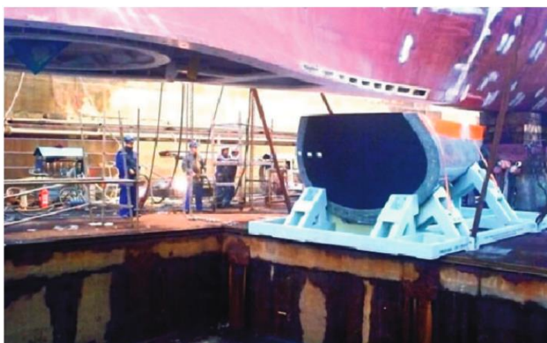
Figura 1-2. Desmontaje del domo de una F-100 para comprobación de corrosión (tomada de [12])
