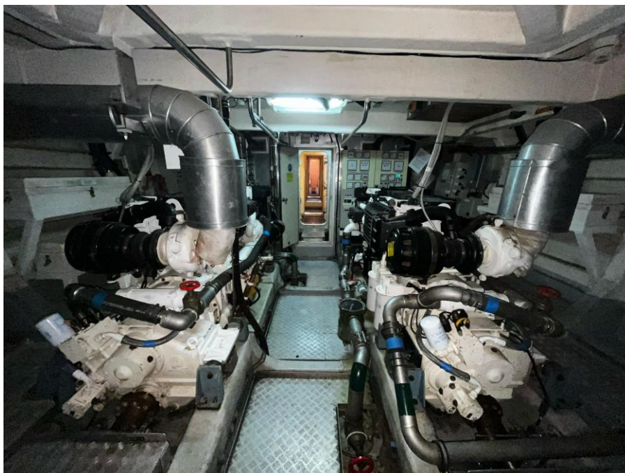
Figura 3-7 Cámara de máquinas de la L.I. GM Chereguini vista desde popa (fuente propia).
